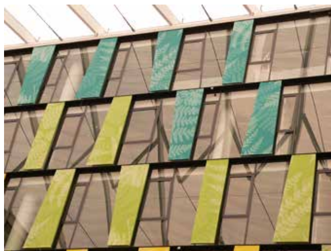
2 Příklad modulového systému lehkého obvodového pláště na fasádě vnitřního atria budovy Amazon Court v Praze; zdroj: ČKLOP.
